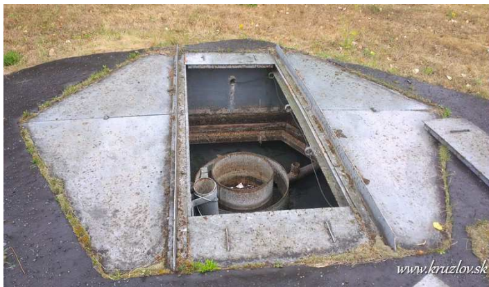
... Dodávka a montáž technologického zariadenia ČOV – aeračný systém, rozvod vzduchu
