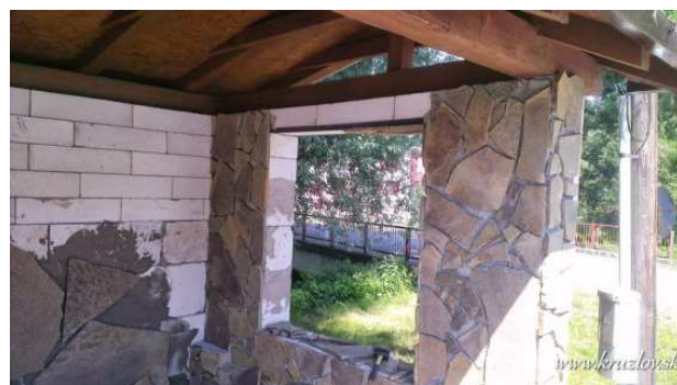
... Výstavba dolnej zastávky pri píle
