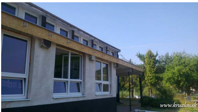
... Oprava strešného žľabu na Základnej škole
