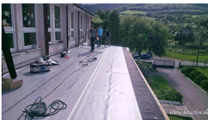
... Základná škola - nová strecha
