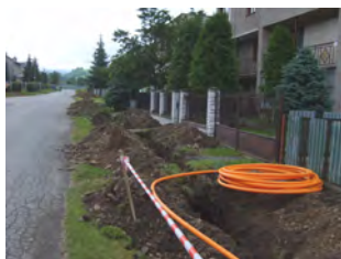
Postup stavby plynovodu
